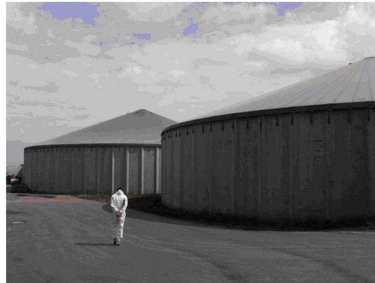
**Figura 8. Copertura rigida per lo stoccaggio di liquame\***
