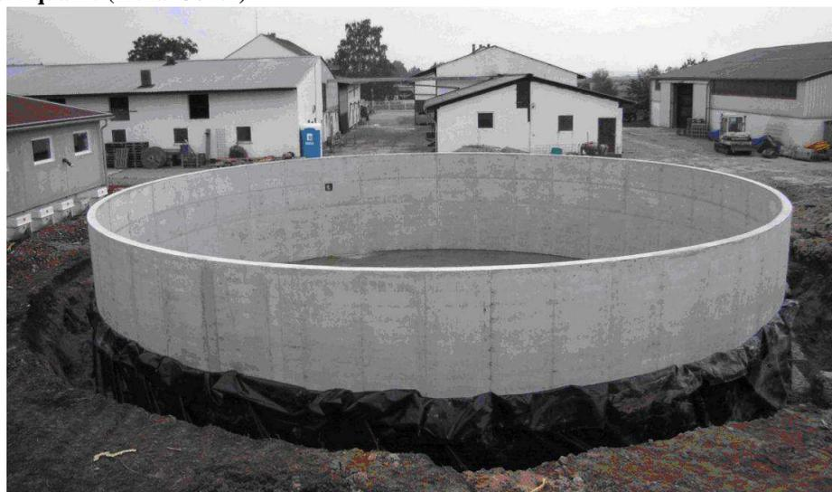
**Figura 9. Vasca di stoccaggio liquame sotterrata in parte con geomembrana a tenuta di liquidi\***
