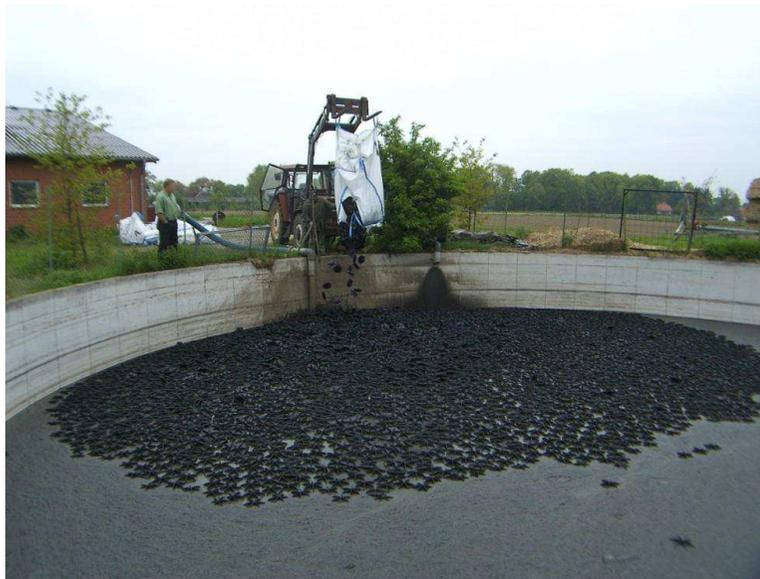
**Figura 7. Operazione di caricamento di piastrelle di plastica geometrica nella vasca di stoccaggio del liquame (Hexa-Cover)\***
