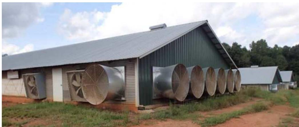
**Figure 61. Edificio per il ricovero di tacchini con ventilazione forzata**
